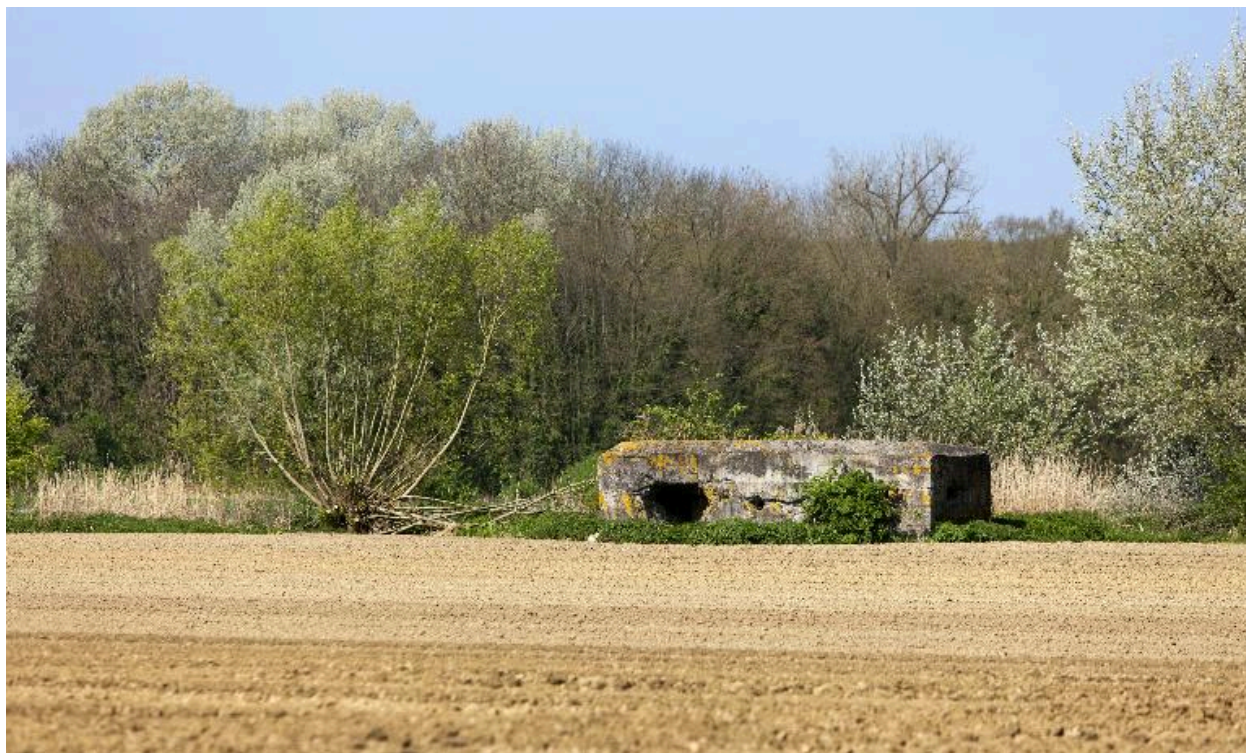
Vue générale vers le nord-ouest
