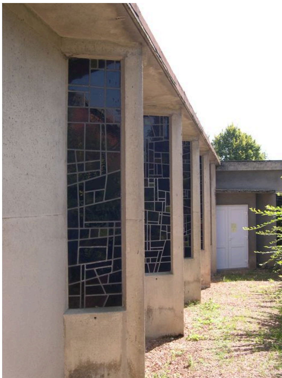
Vue des fenêtres de la façade ouest, depuis le nord.
