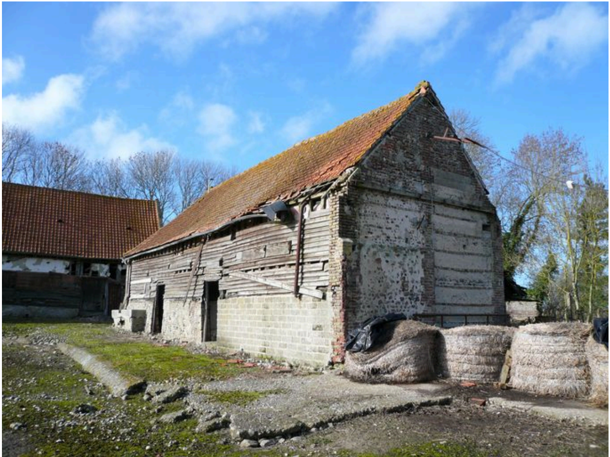
Vue des écuries au nord.
