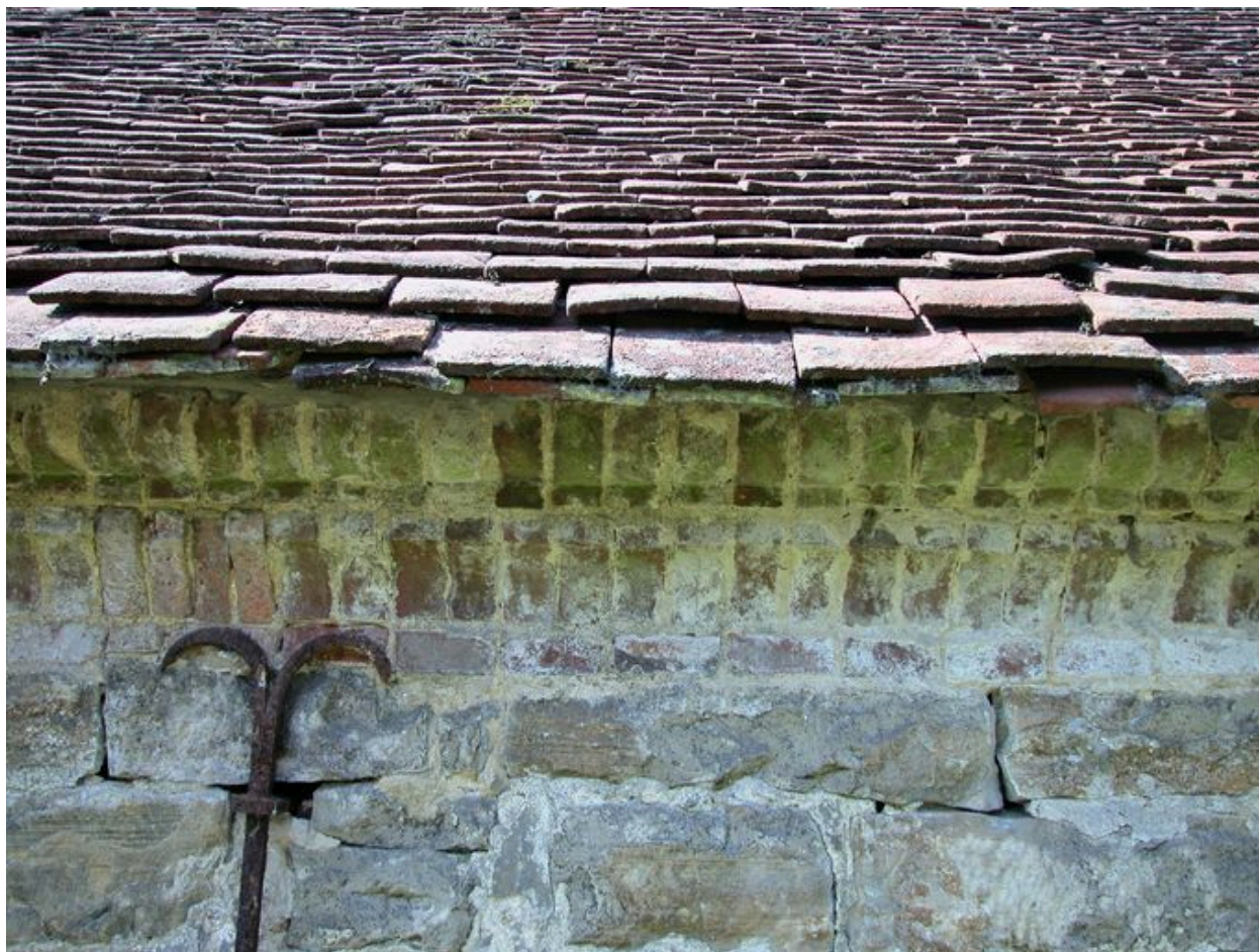
Détail de la corniche moulurée.
