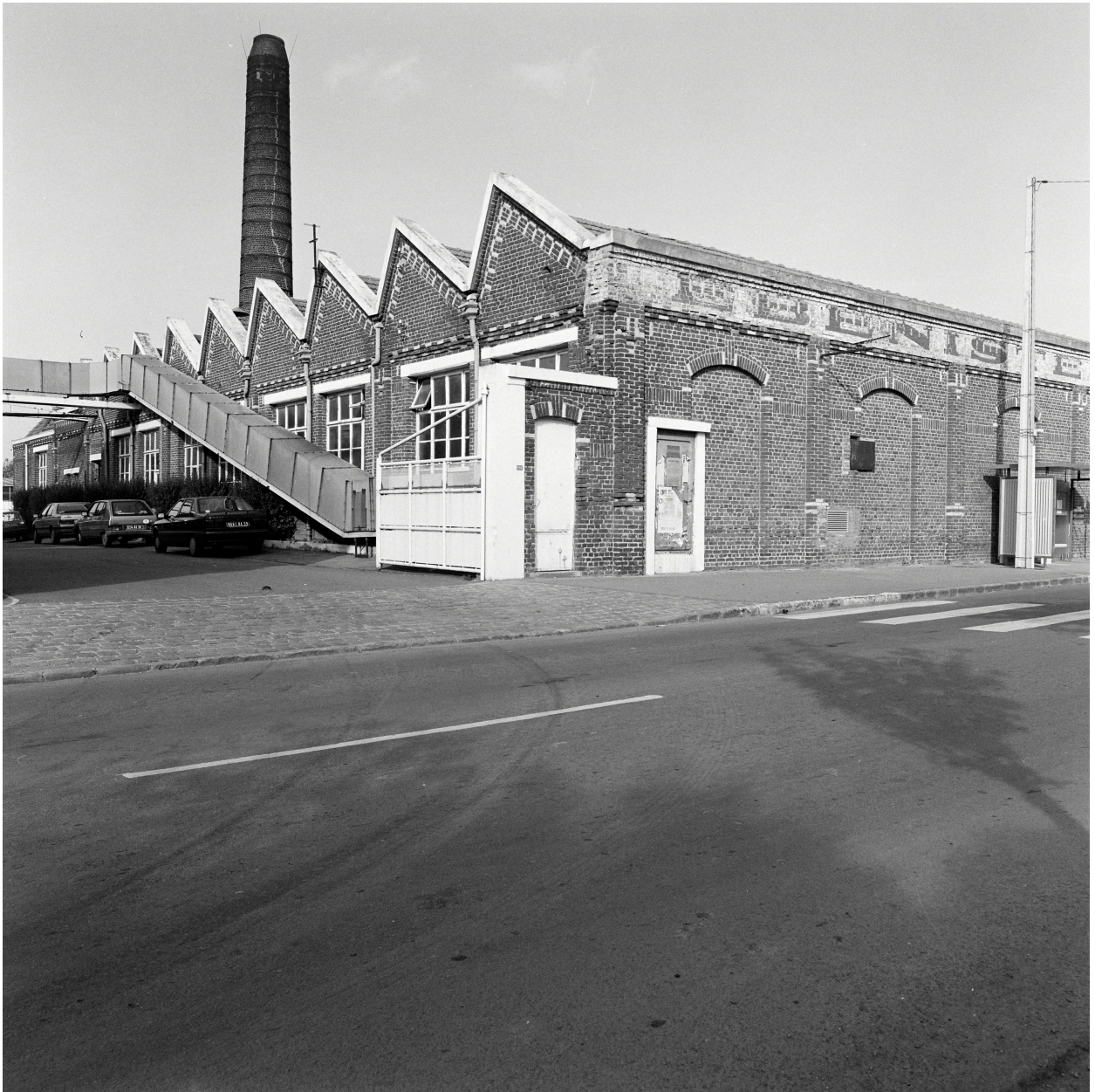
Atelier de fabrication. Élévation sur cour depuis la rue.
