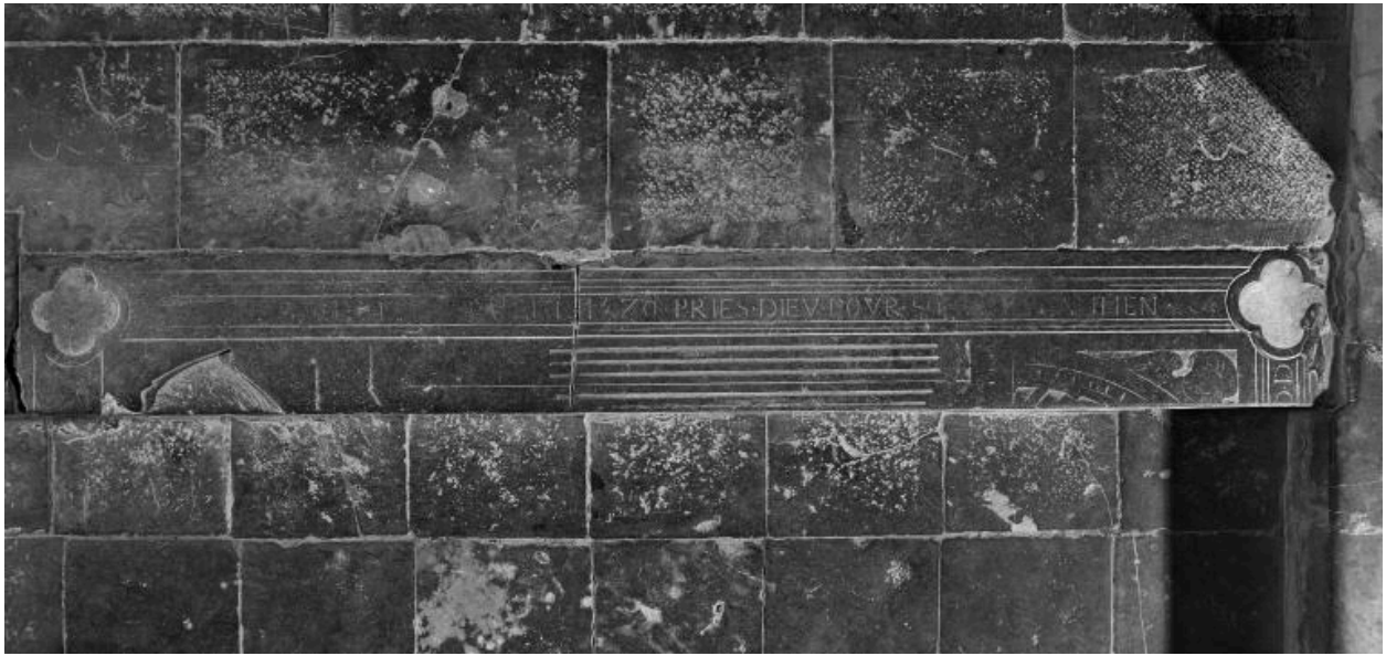
Élément de la dalle.
