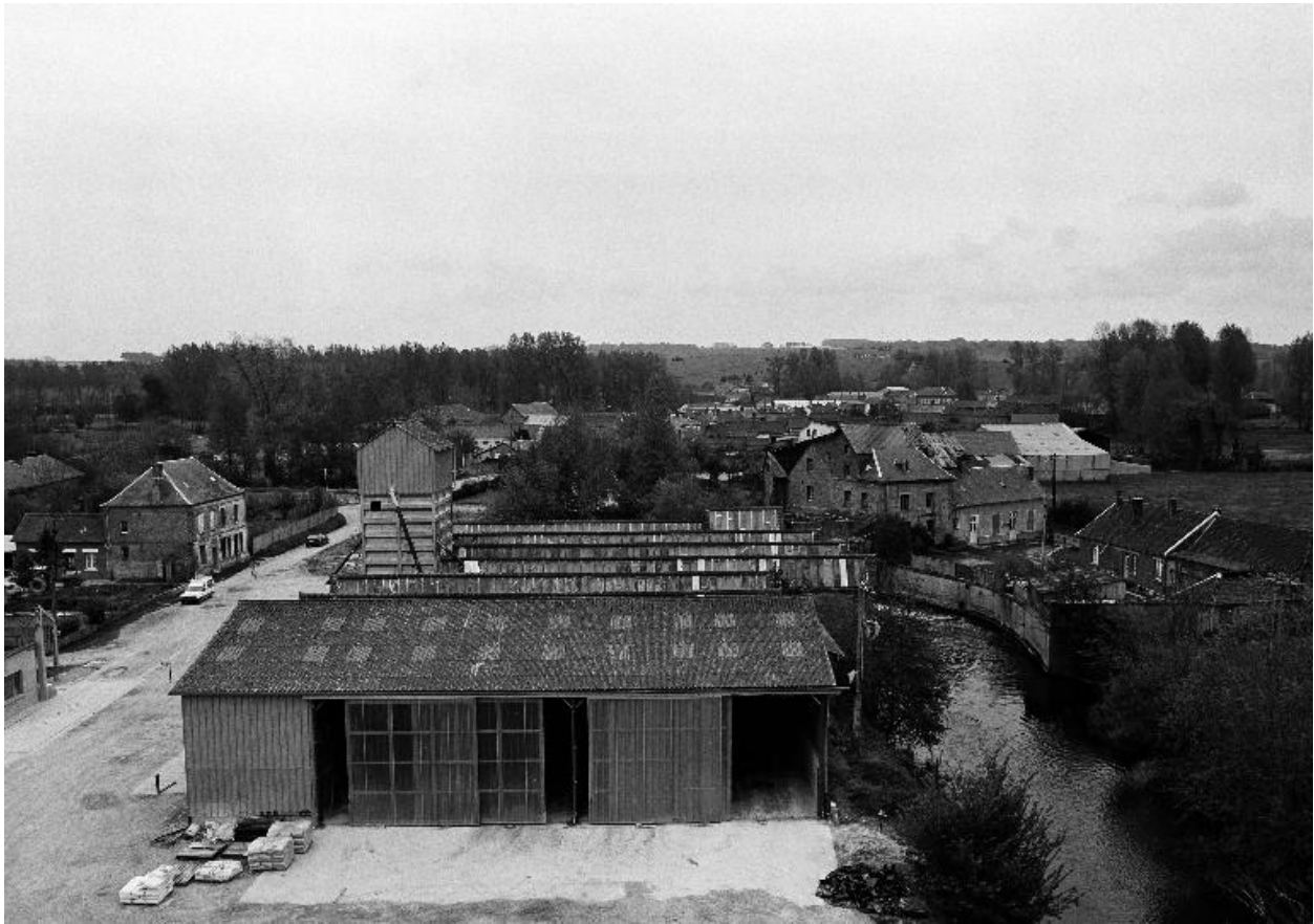
Vue générale, flanc nord.
