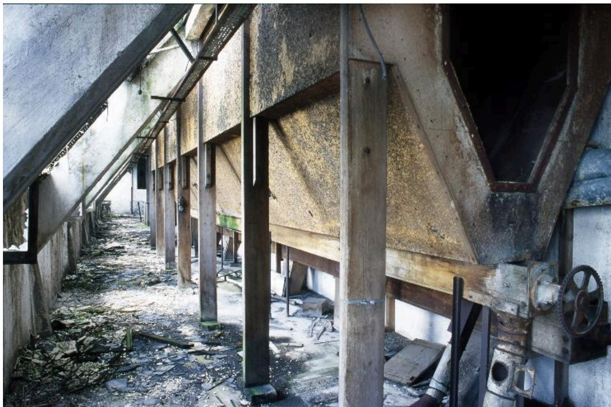
Bâtiment du nettoyage. Troisième niveau de comble. Mélangeur ?
