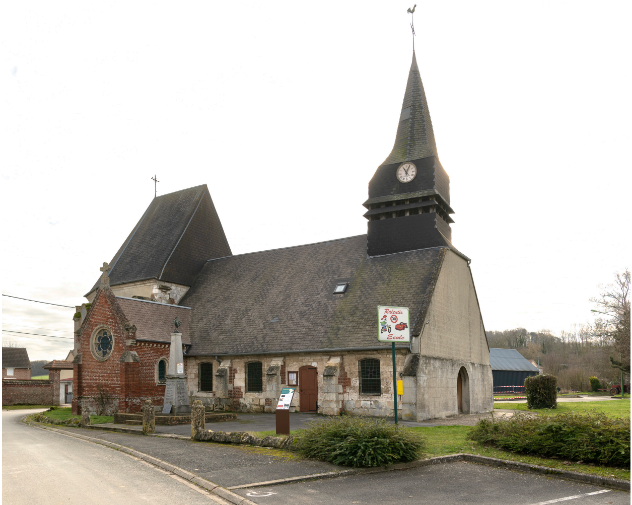
Vue générale depuis le nord-ouest.
