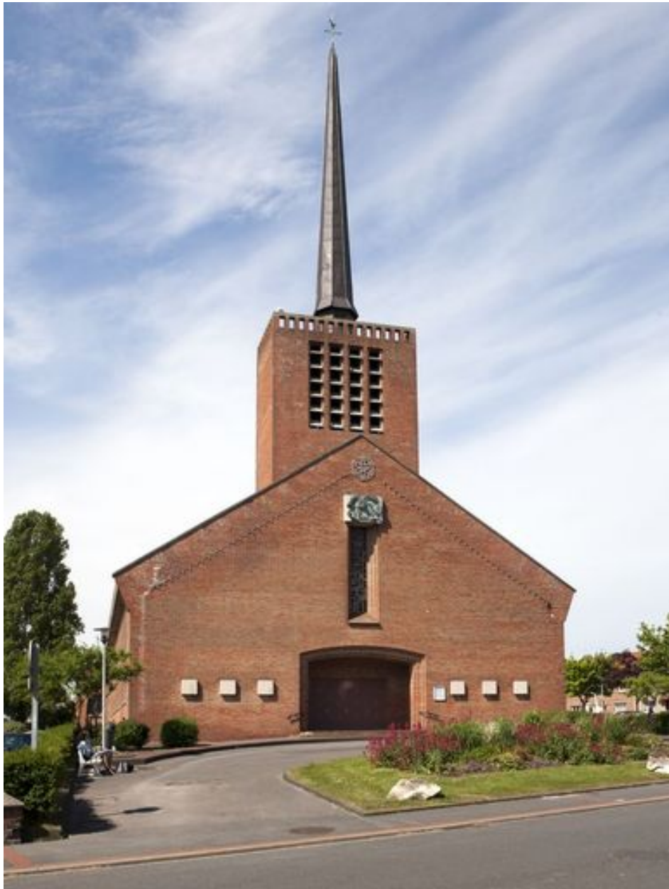
Élévation antérieure de trois quart gauche.
