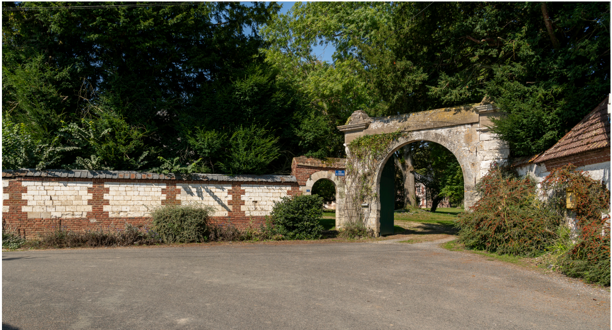
Vue générale de l'entrée depuis la rue du Château, vue depuis le sud.
