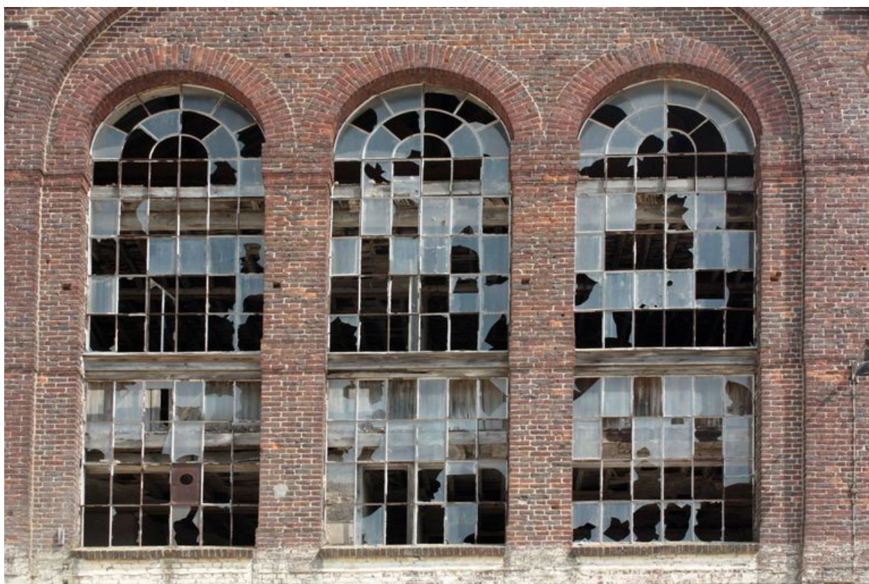
Détail du triplet d'ouvertures de la distillerie de 1880, façade antérieure.
