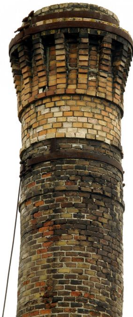
Détail du couronnement d'une des trois cheminées.
