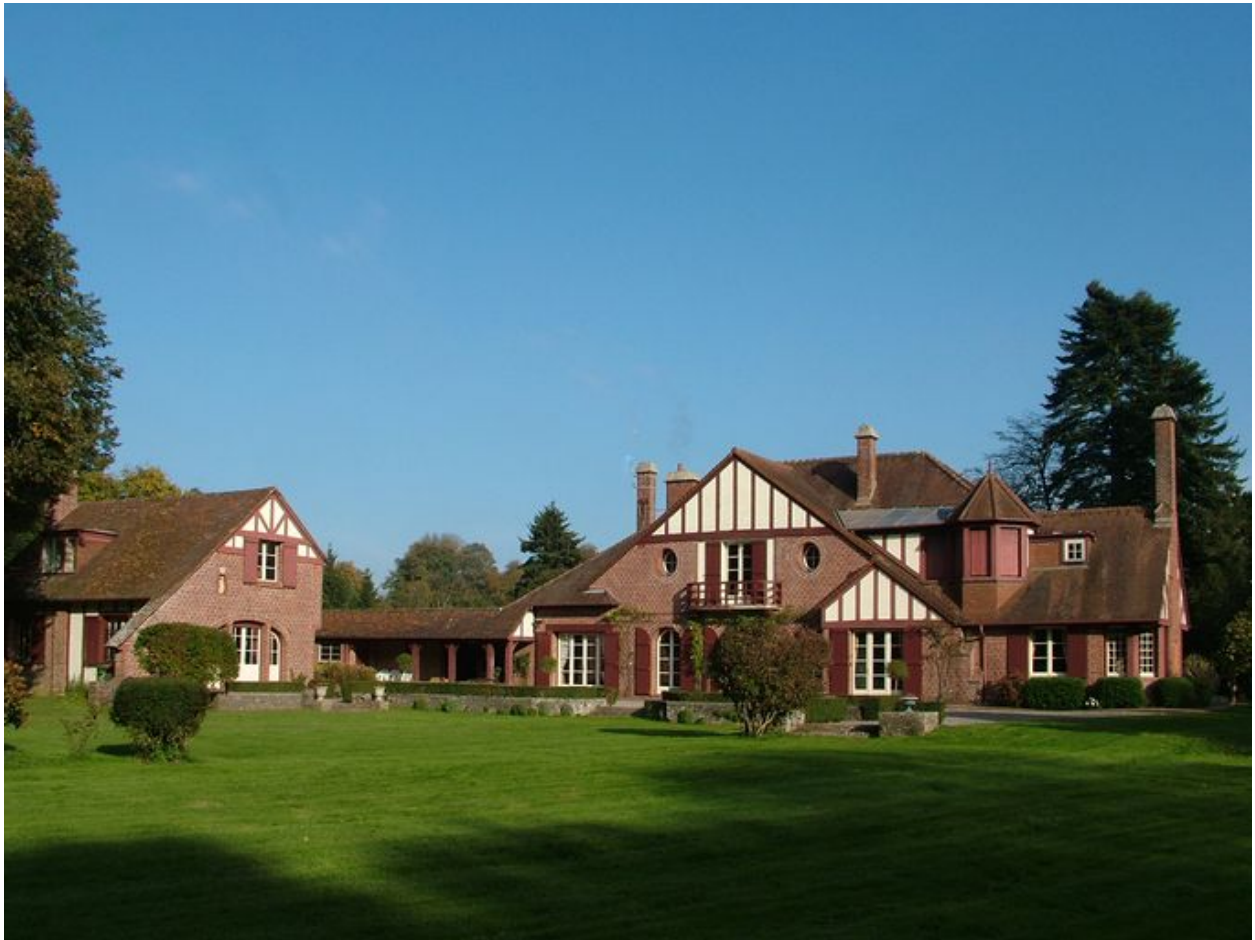
Vue générale depuis l'arrière.
