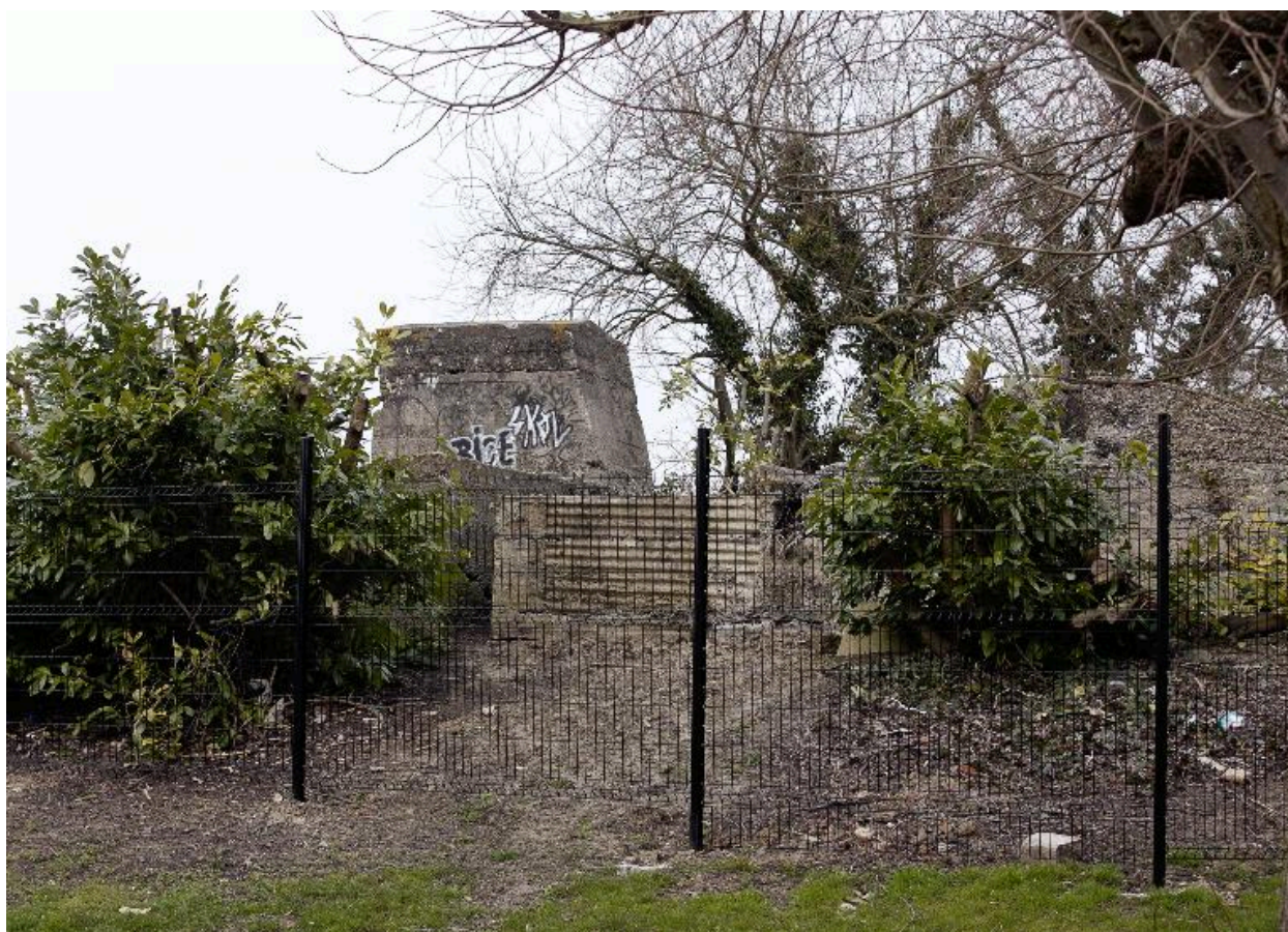
Vue vers le nord, depuis la rue Delaval. La tourelle d'observation
