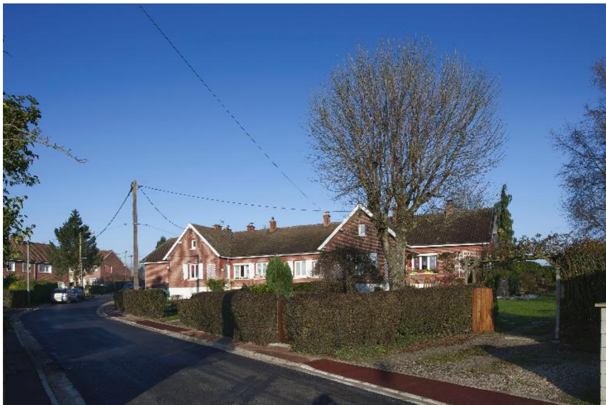
Vue des logements à deux unités d'habitation.
