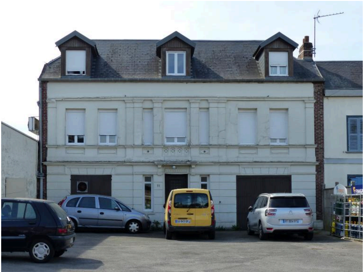
Vue de la façade principale du logis.
