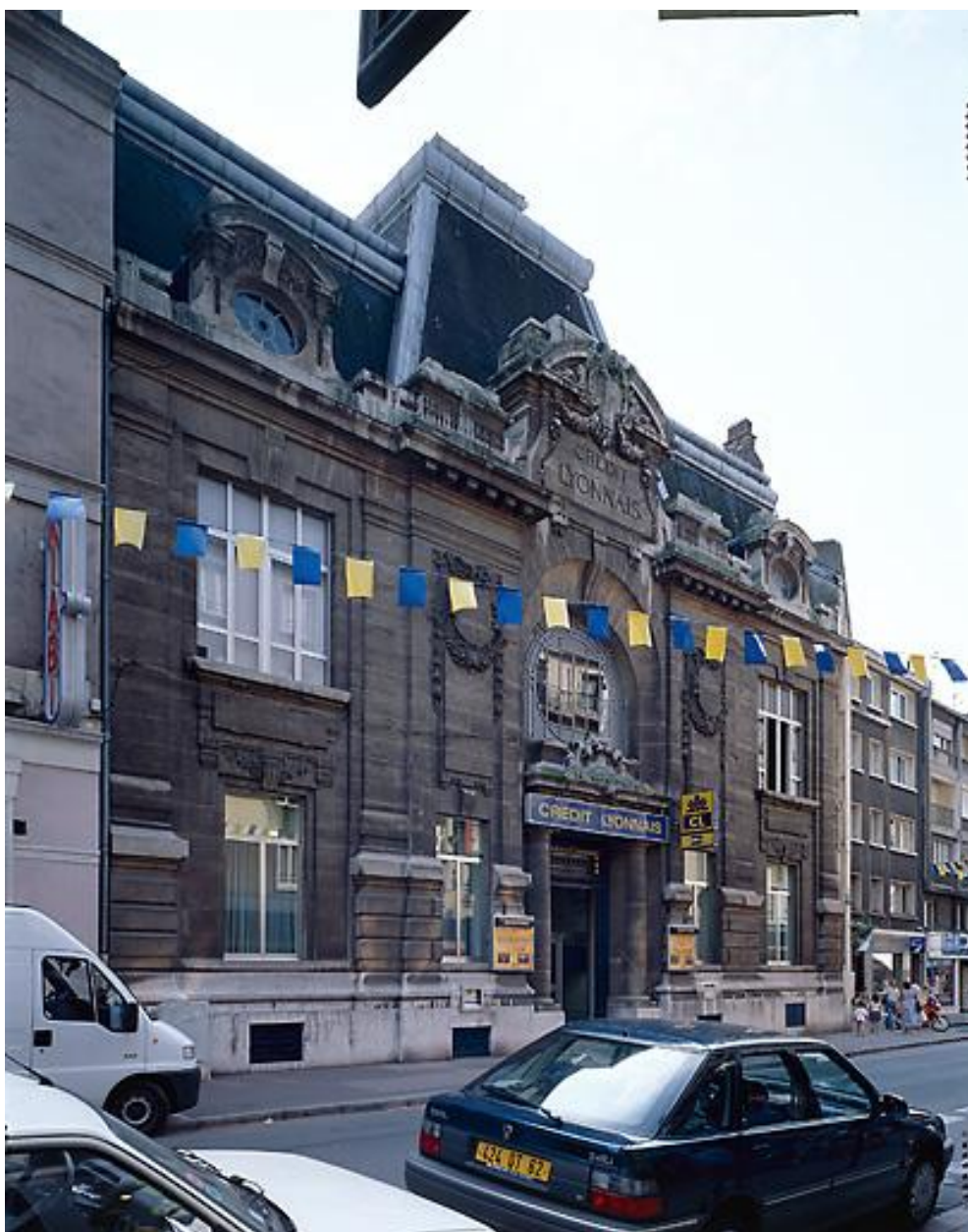
Vue générale sur voie.
