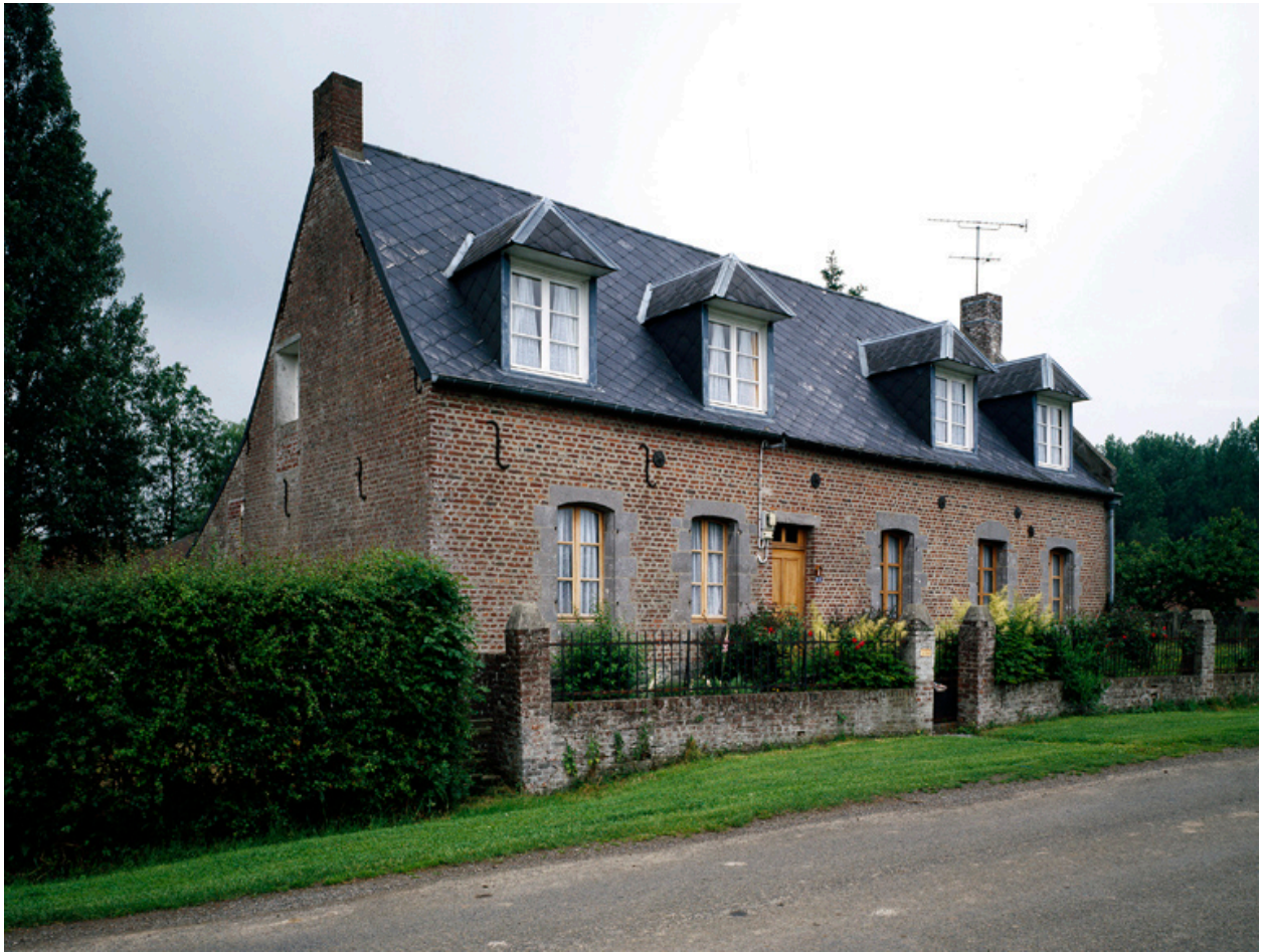
Vue générale sud-ouest du logis.
