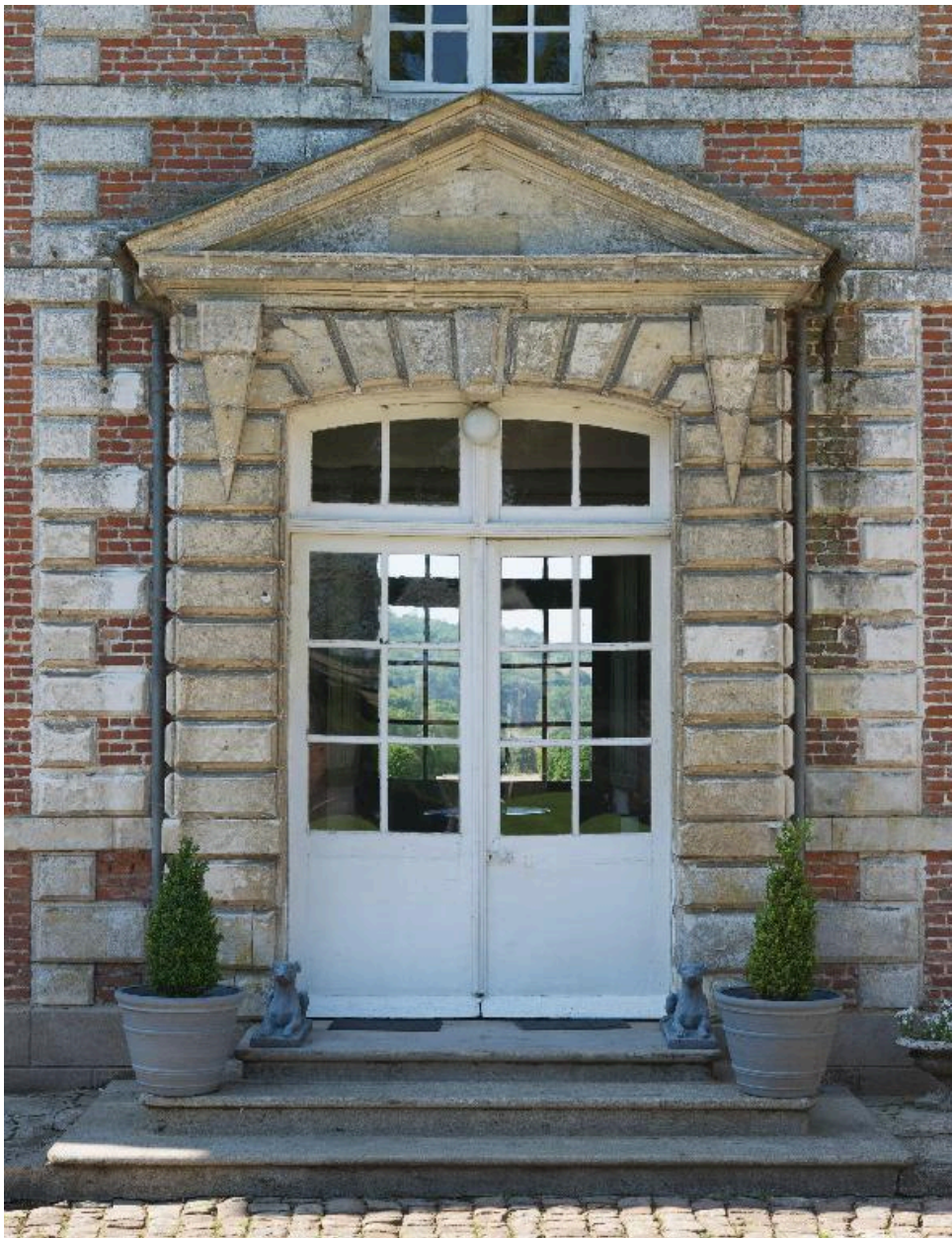
Porte principale du logis sur cour.
