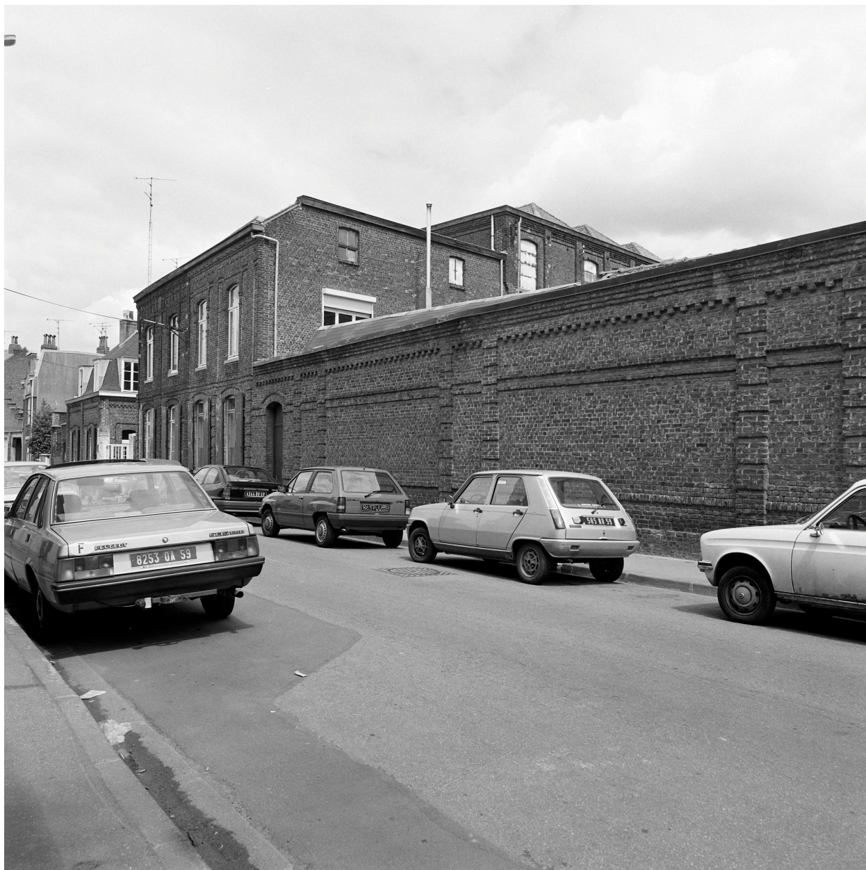
Élévation rue des Prés, vers le Nord.
