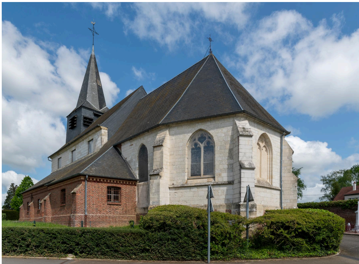
Vue générale depuis le sud-ouest.
