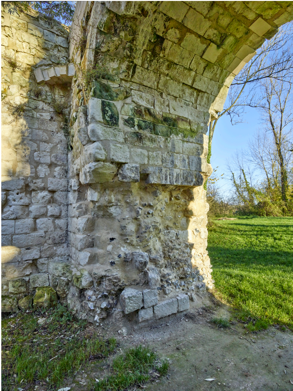
Détail de la maçonnerie du châtelet d'entrée.
