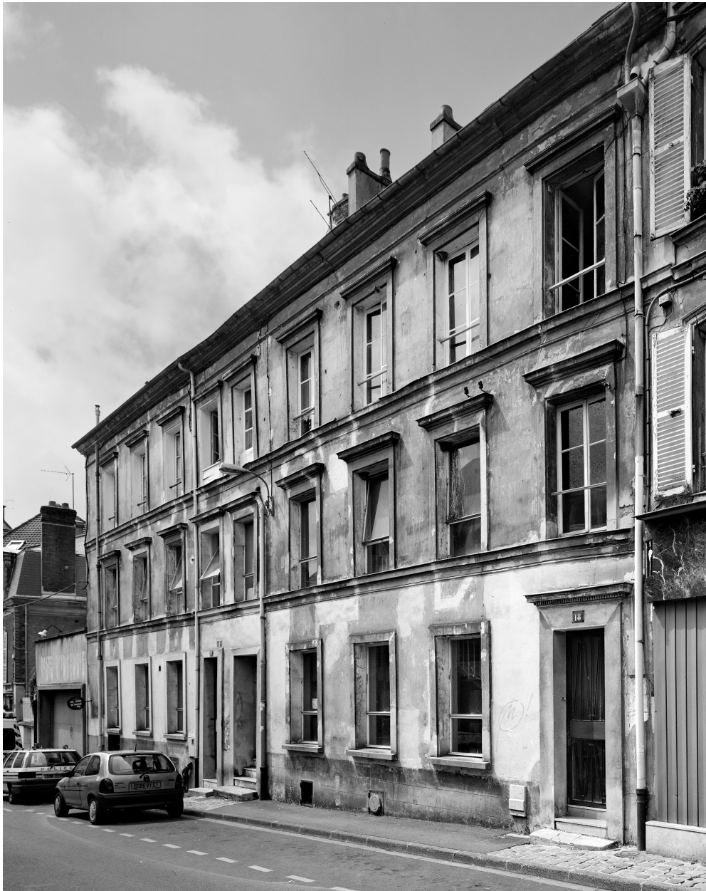
Vue de la façade sur rue.
