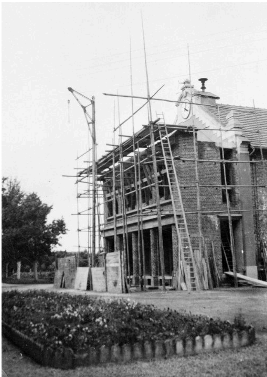
Extension de l'usine (AP).
