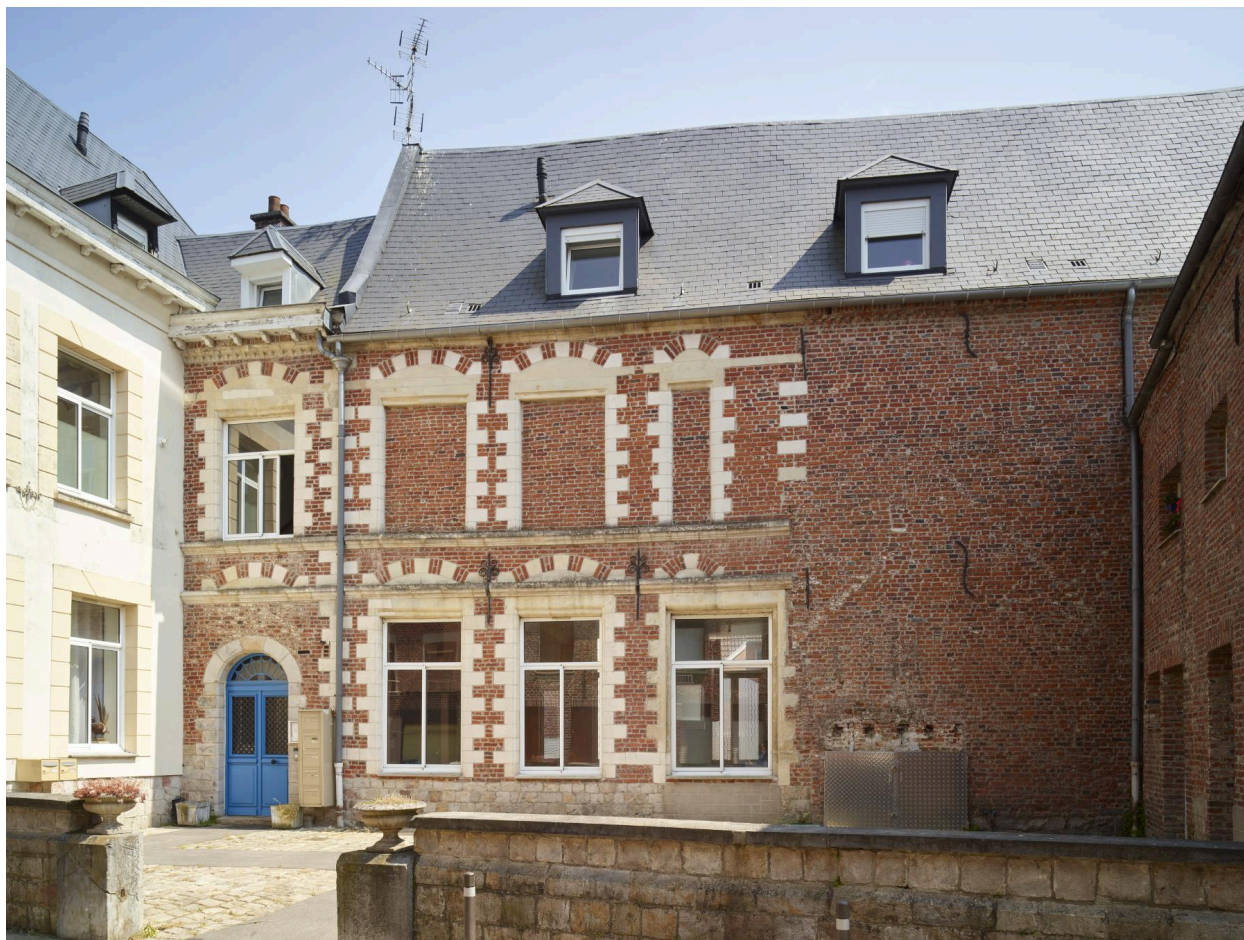
Partie centrale de la façade avant sur la rue Théau, vue de face.
