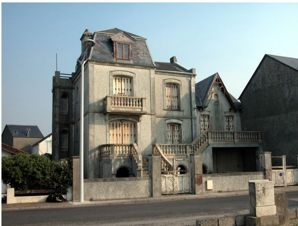
Rez-de-chaussée surélevé, 35 rue du Maréchal-Joffre (1988 AZ 53).
