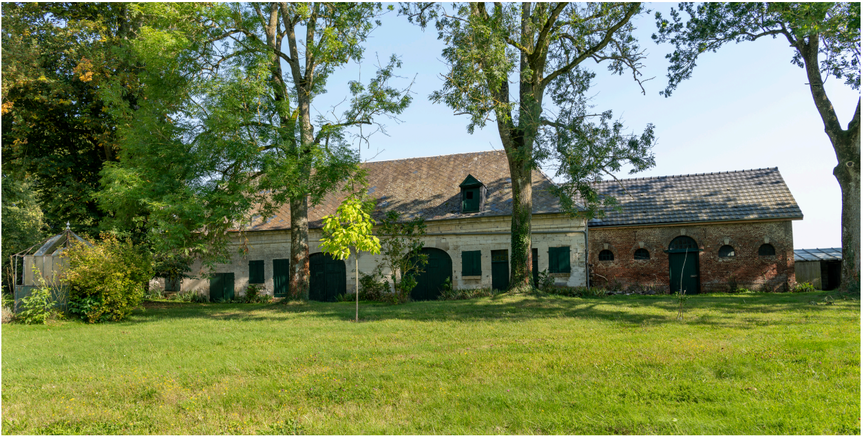
Anciens garages et écurie, vue depuis l'ouest.
