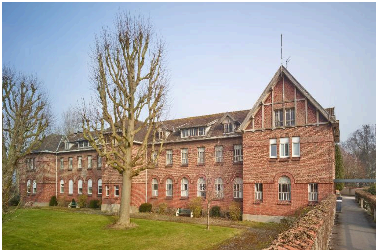
Bâtiment d'hospitalisation dit pavillon G7, élévation donnant sur le jardin intérieur commun avec le pavillon G6, vue générale prise de trois quarts droit.
