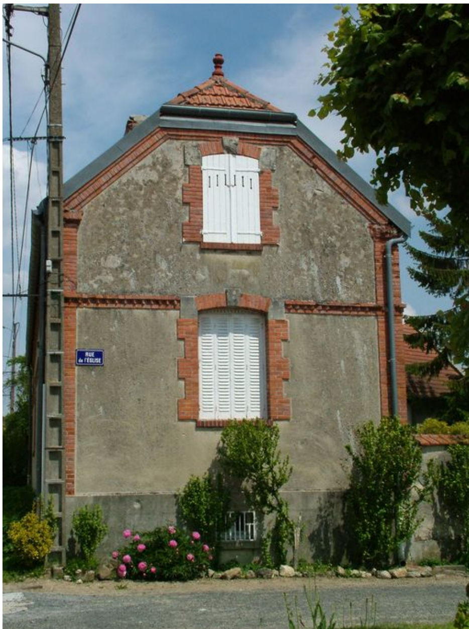
Vue du pignon de la maison.
