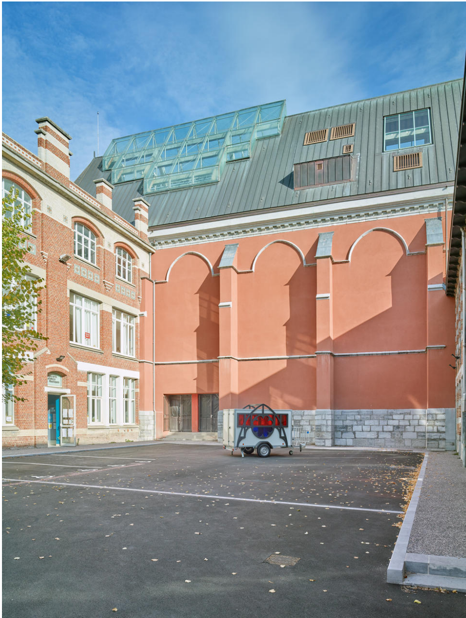
Vue de l'élévation sud donnant sur la cour de l'ancien collège.
