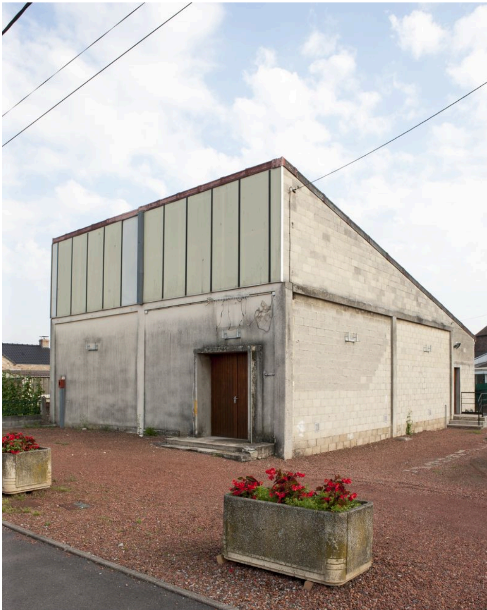
Élévation antérieure et flanc droit.
