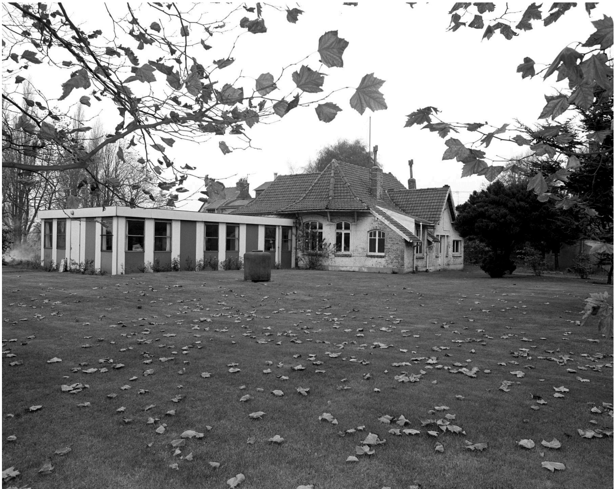
Bureaux. Vue prise vers le nord.
