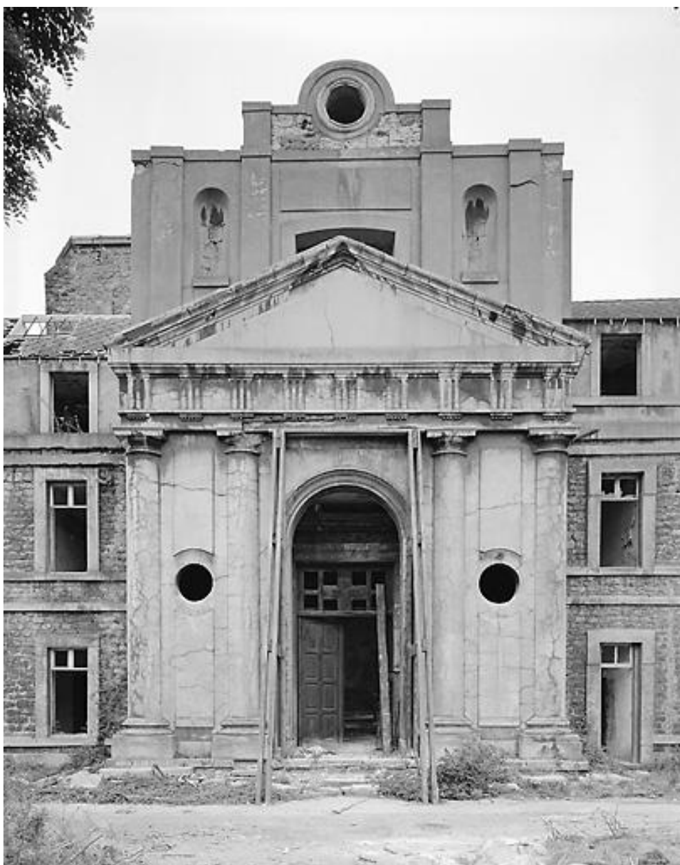
Chapelle, façade sur cour.
