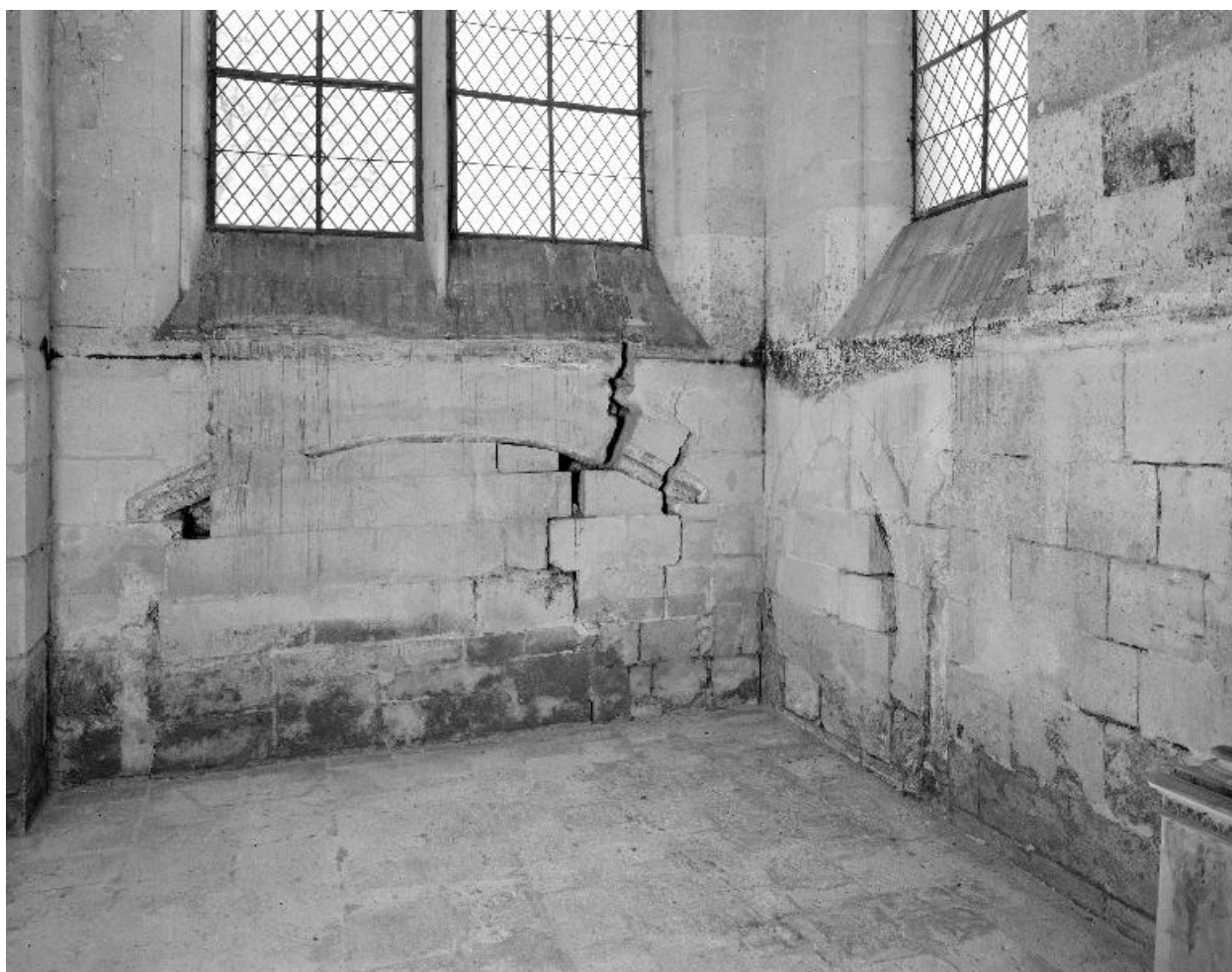
Détail des murs est et sud de la chapelle sud du chœur : enfeu et arcades murés.
