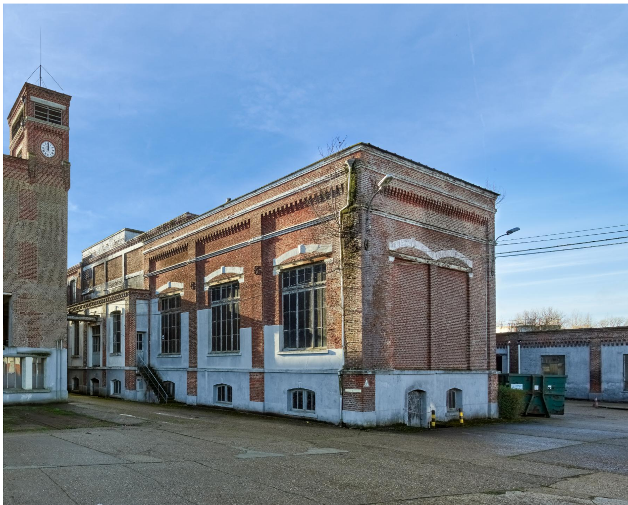
Vue générale nord-est de la salle des machines attenante à l'atelier de fabrication.
