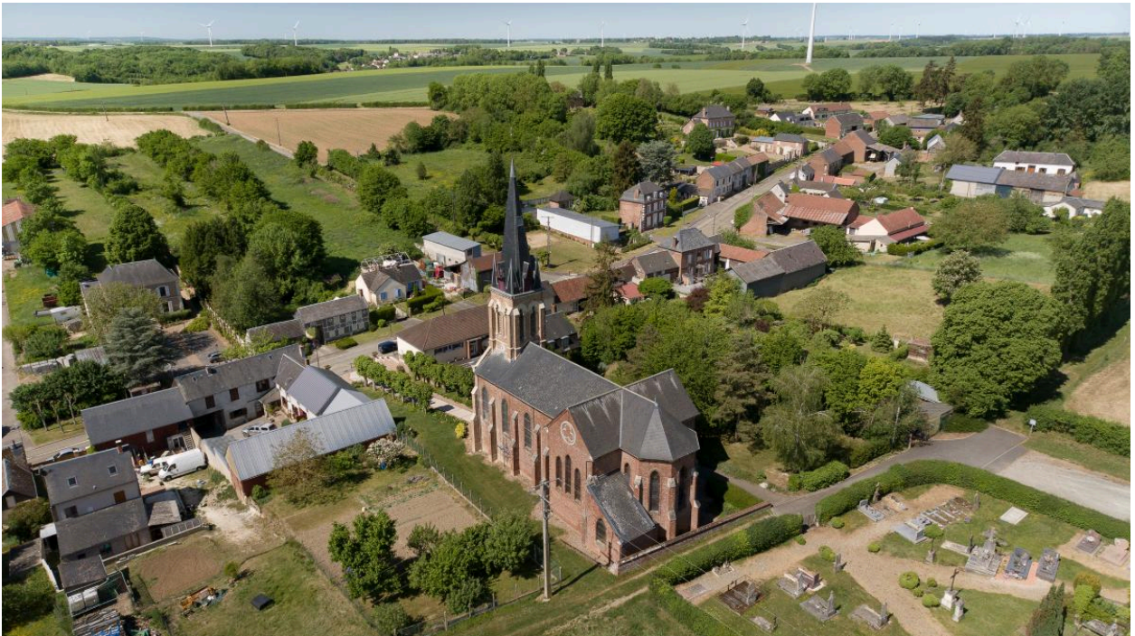
Vue aérienne de l'église depuis le sud-est.
