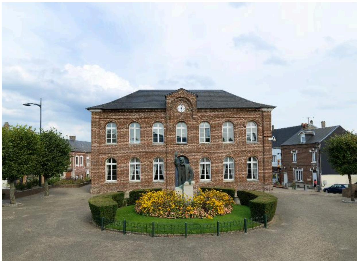
Vue générale depuis la place Jean-Jaurès.
