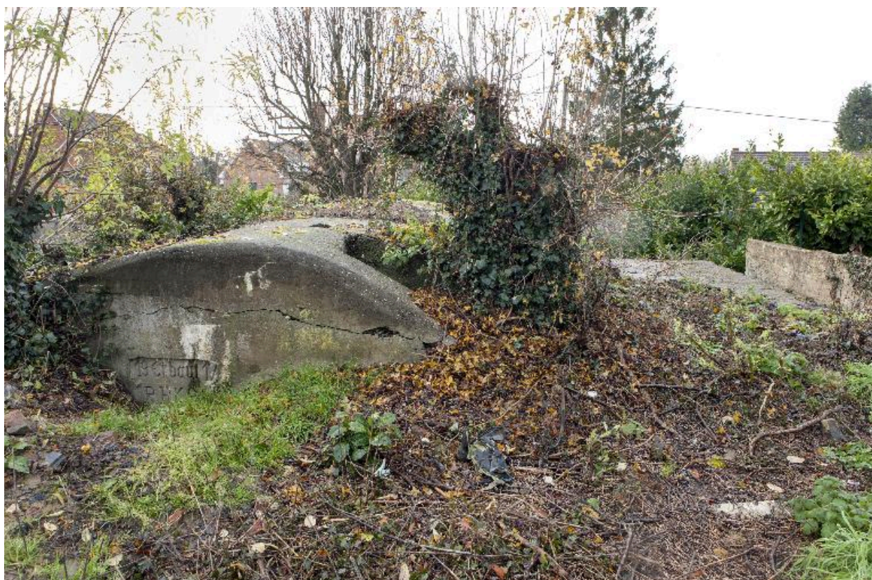
Elévation nord. Inscription surmontant une des entrées nord
