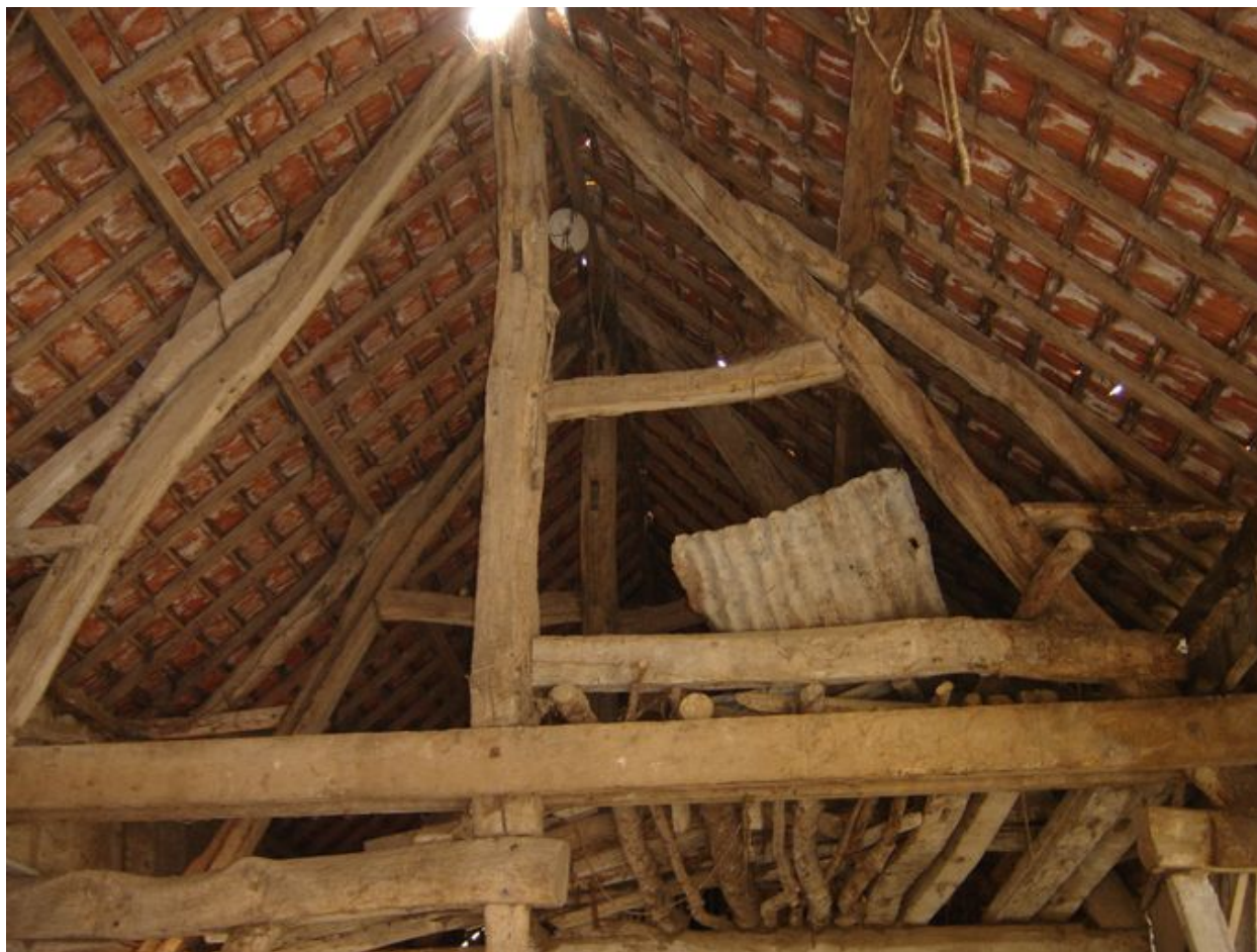
Vue détaillée d'une ferme de la grange.
