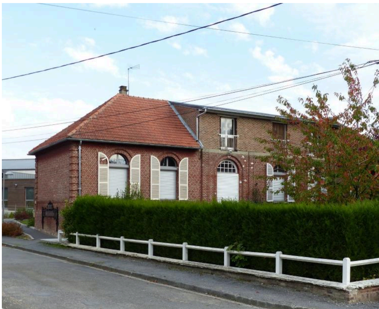
L'ancien hospice, vue depuis la rue Sainte-Radegonde.
