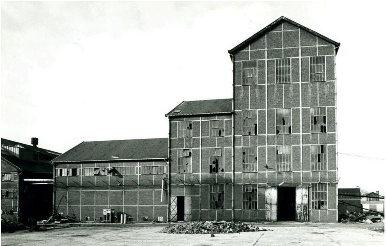
Atelier de fabrication, flanc est.
