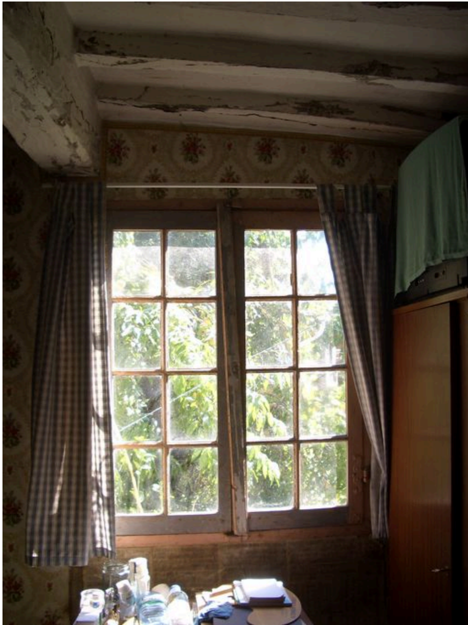
Vue de la fenêtre de la chambre avec système de fermeture à tourniquet.
