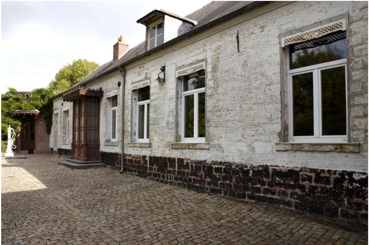
Vue de l'élévation sur cour du bâtiment abritant les pièces de réception.
