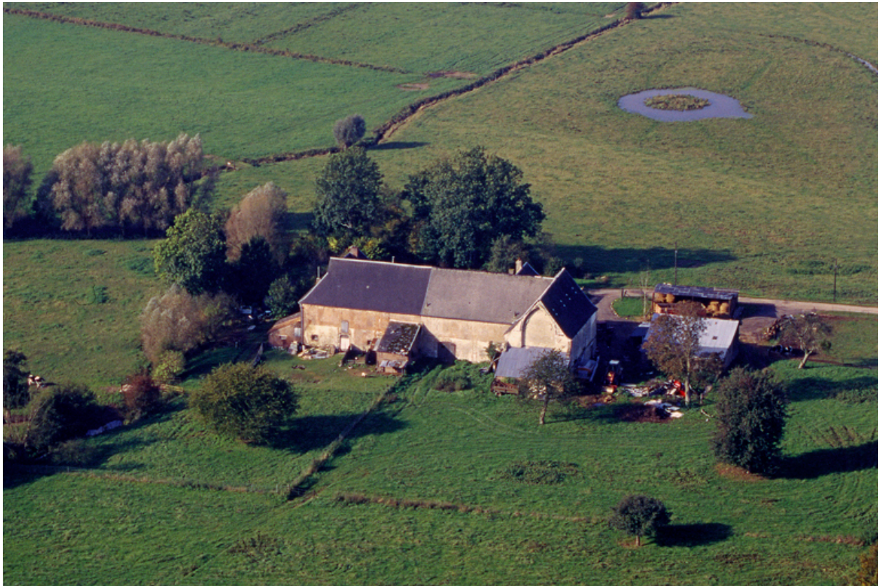
Vue aérienne nord-est des bâtiments subsistants de l'abbaye et du site.
