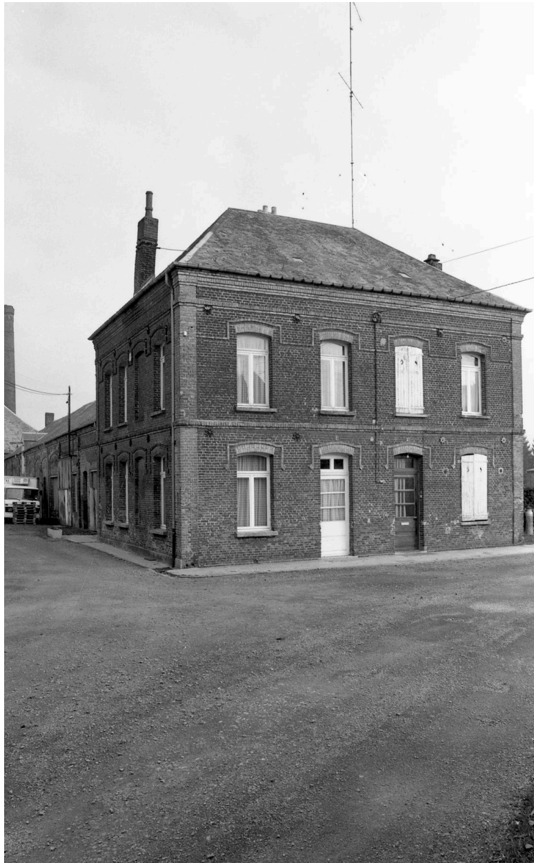
Logement de contremaître existant en 1989, aujourd'hui détruit.
