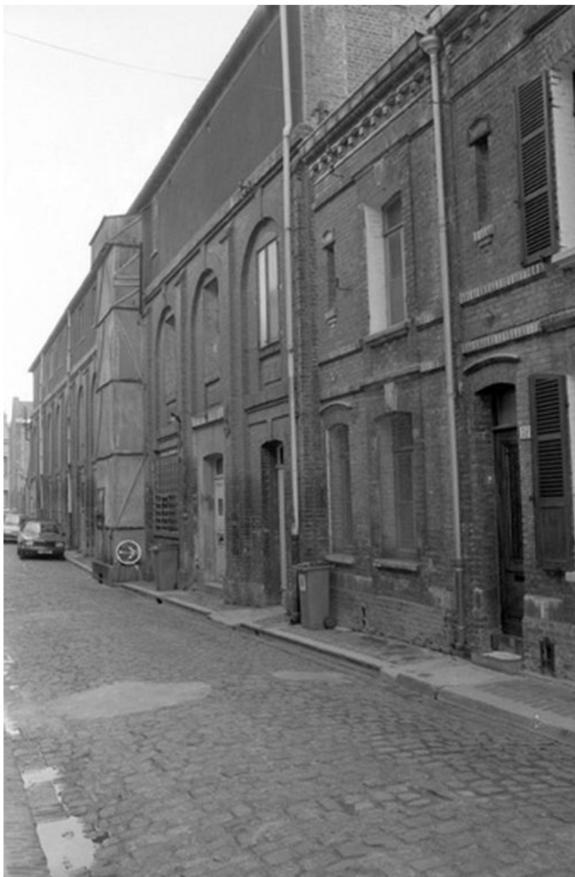
Atelier de la rue Guérard, façade nord.
