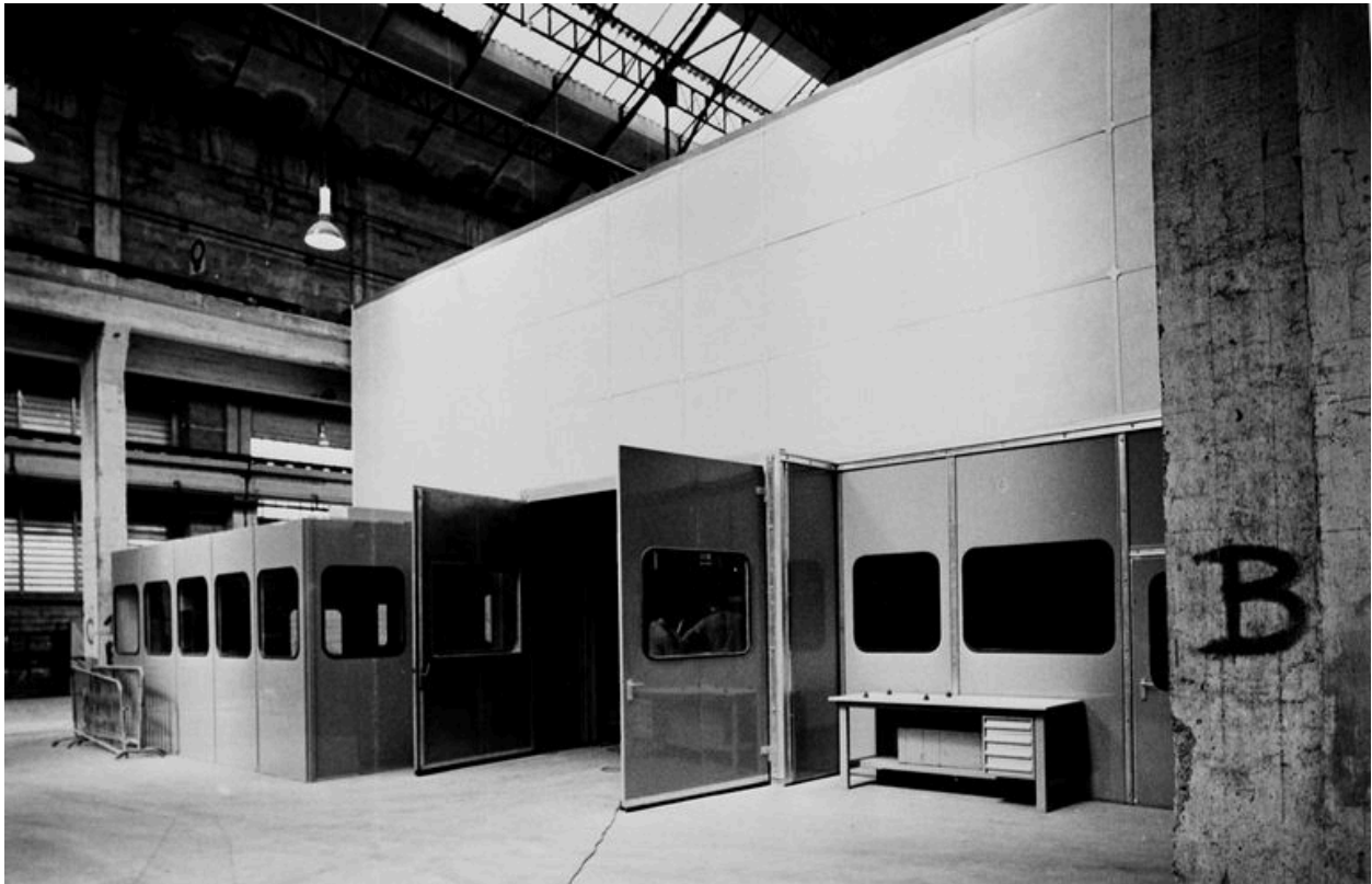
Atelier de fabrication : vue intérieure, vers 1925 (AP).
