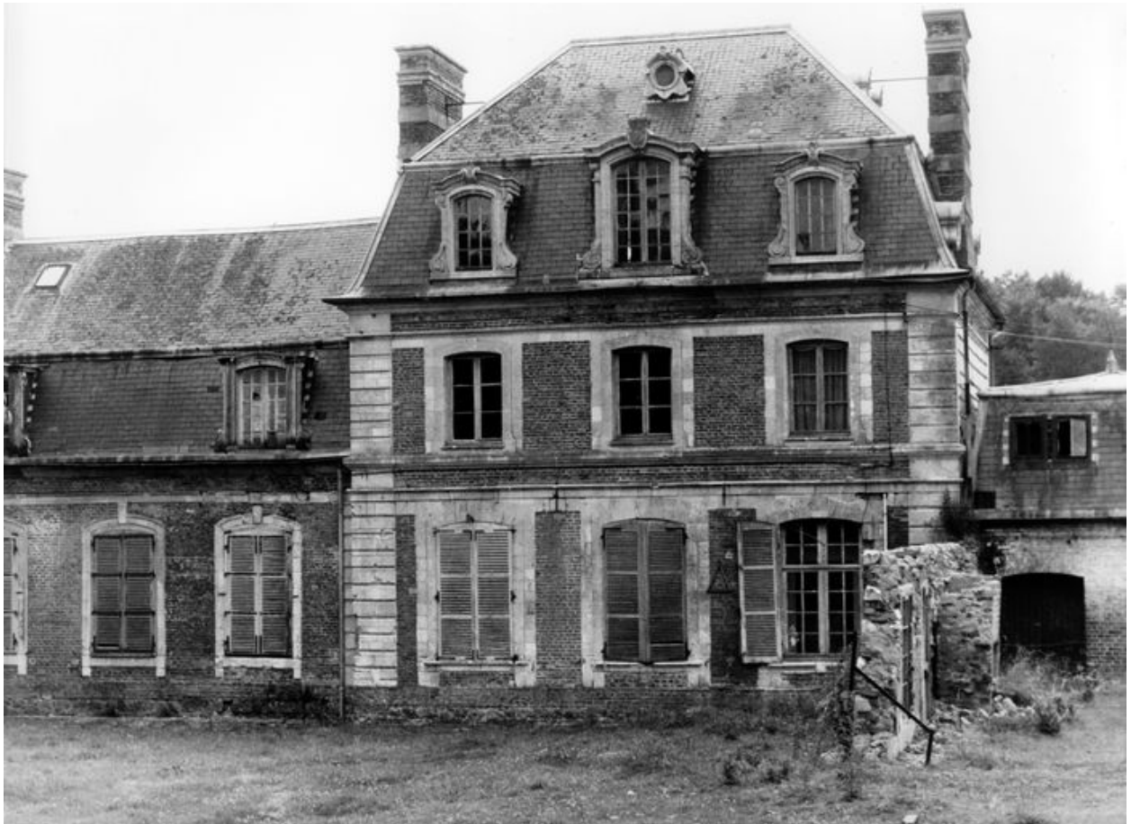
Vue partielle avec le pavillon, 1980 (archives privées).
