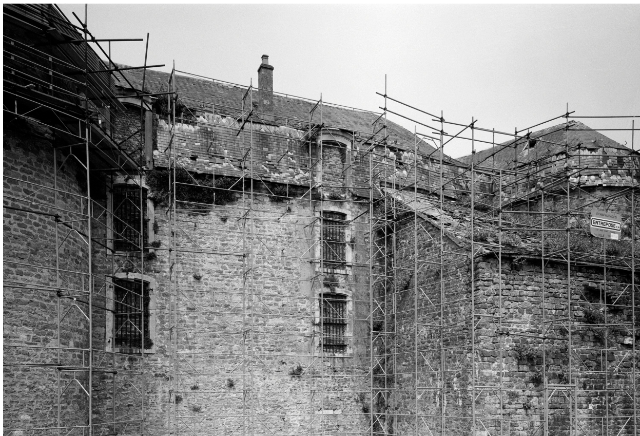
Façade sud, toiture en cours de restauration.
